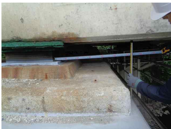
받침장치 연단거리 측정
